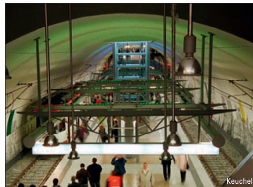
Dortmunder Ost-West-Tunnel eröffnet – ab Seite 14
